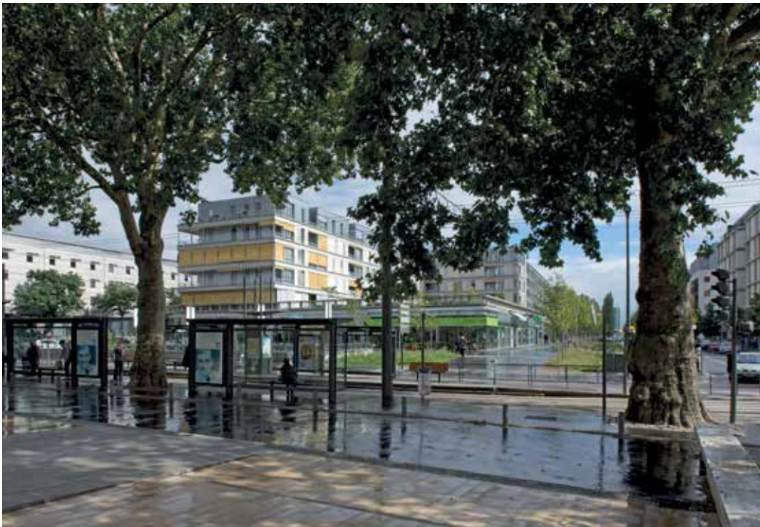
Sur les rives de Meurthe, un immeuble en ville, avec des commerces, des parkings silos et des logements (les Deux-Rives), a été créé à partir du programme d'une supérette périurbaine.
